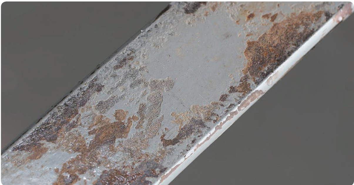
[그림 6-9] Fretting corrosion
