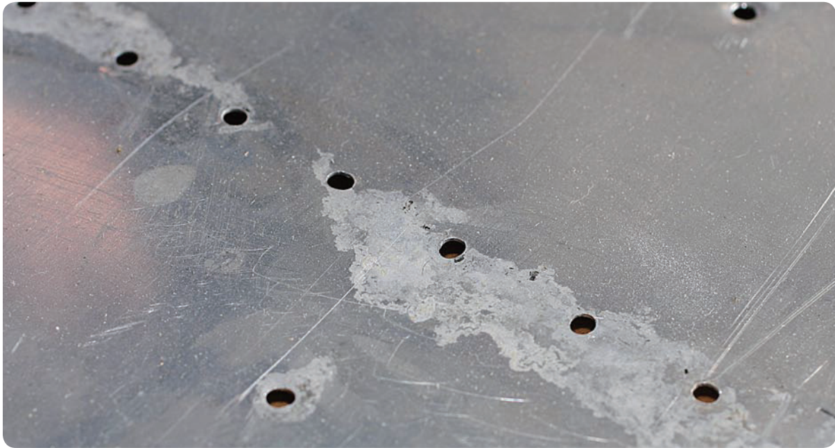
[그림 6-4] Surface corrosion
