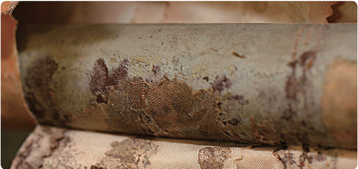
[그림 6-14] Rust on structural components
